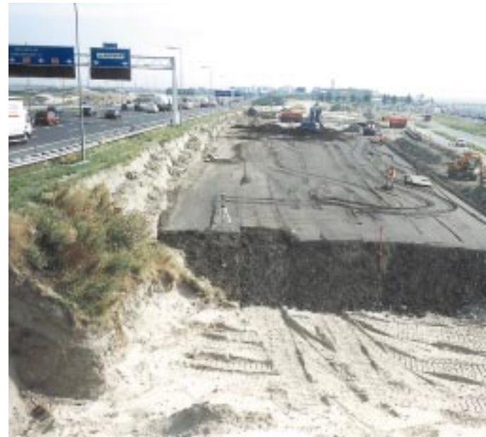
Wegophoging met gerijpte baggerspecie bij A5 Schiphol.
